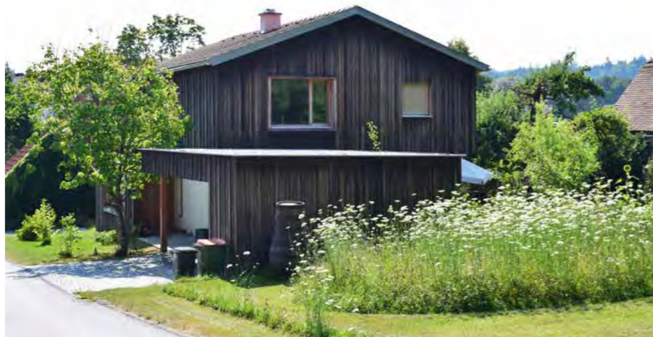
Foto: baustelle land
